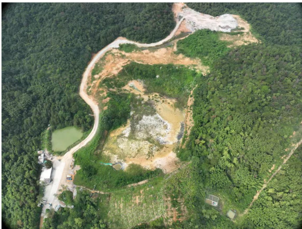
图 2-2 云浮市云城区建筑垃圾消纳场
